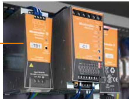
ESG: Todo tipo de identificación para equipos: etiquetado sencillo de señalizadores para una identificación rápida de los componentes
