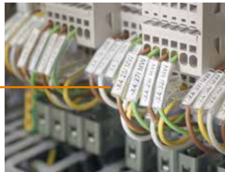
TM-I: Los señalizadores insertables para cables se pueden instalar antes o después de montar los manguitos retráctiles
